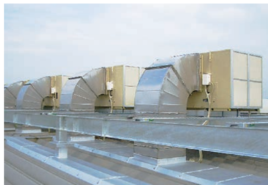
▲ クールクリーンファン(CC) 横吹出形 屋根上設置
