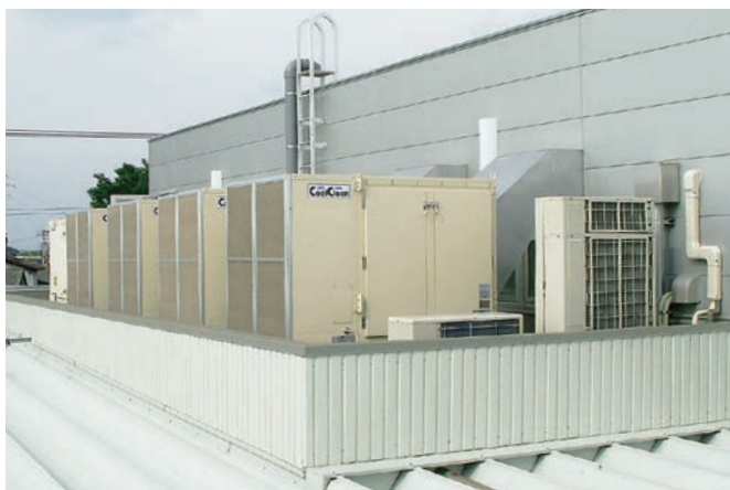
▲ クールクリーンファン(CC) 横吹出形 屋根上設置
