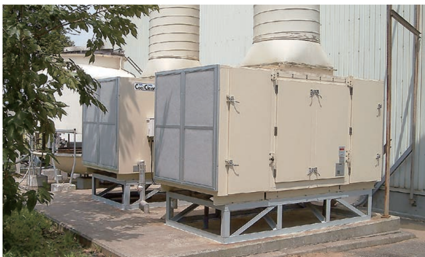
▲ クールクリーンファン(CCF) 上吹出形 地上設置
