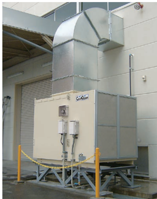
▲ クールクリーンファン(CCF) 上吹出形 地上設置
