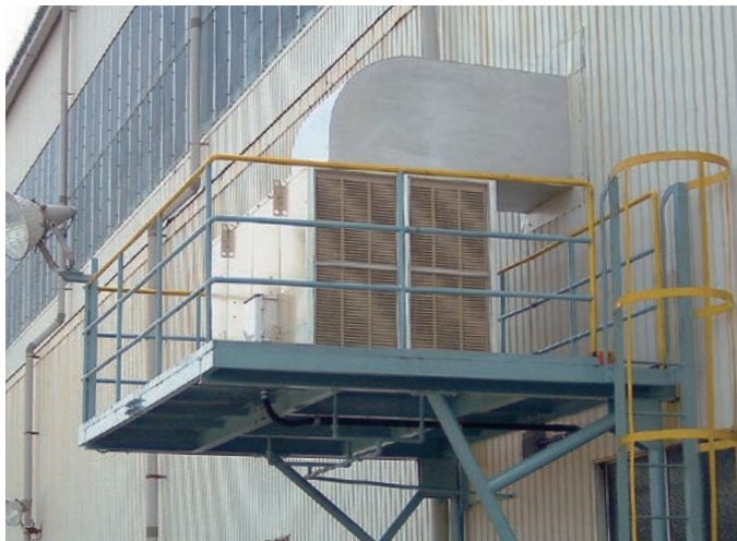
▲ クールクリーンファン(CC) 上吹出形 地上架台上設置
