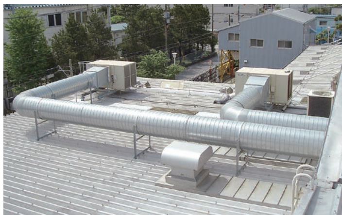
▲ クールクリーンファン(CC) 横吹出形 屋根上設置
