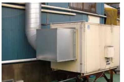
はじめは防暑対策のために導入したのですが、製品からの大風量給気を見て「建物の陽圧化に使える」と思いました。いまでは他の工場を含め工場内の衛生管理の一環として1年を通じて活用しています。カマクラのクールクリーンファンは外気を取り込む際、水の壁を通して給気するため、室内にはきれいな空気となって入ってきます。当社は衛生管理のために外部機関にお願いして定期検査を実施していますが、おかげさまで毎回好成績を維持しています。
